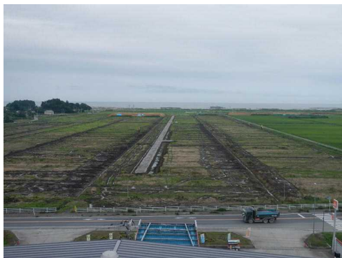
津波被災状況 (作田前地区（新地町）)
