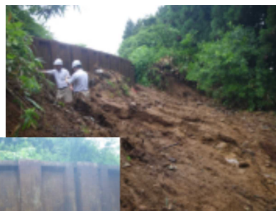
法面崩落による 水利施設破損
