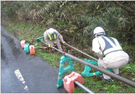
バリケード再設置作業
