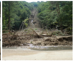
南会津町八総字番屋地内 林地被害
