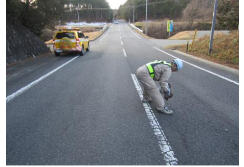
小動物死骸処理作業
