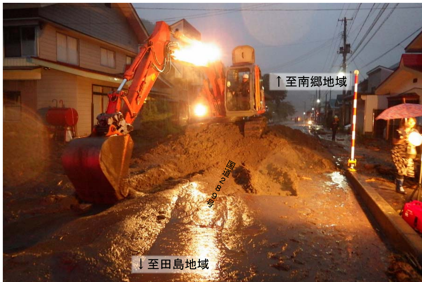
国道289号土砂流出箇所での排土状況（南会津町東地内）
