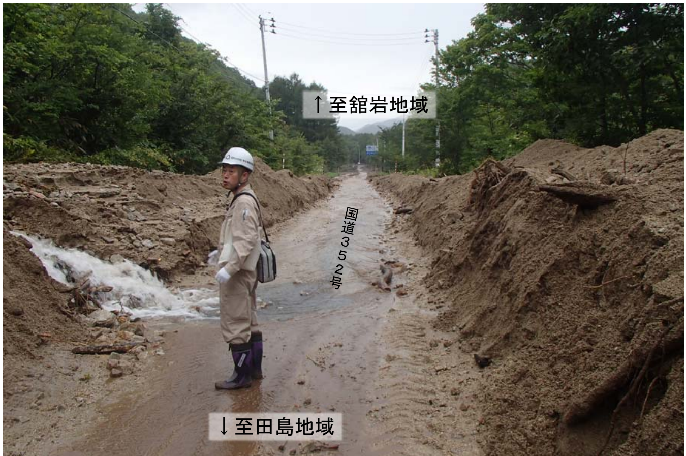
国道352号土砂流出（南会津町番屋地内）
