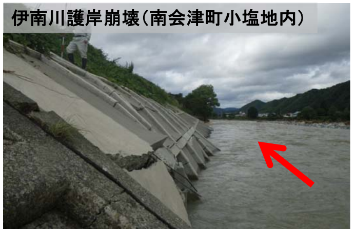
伊南川護岸崩壊(南会津町浜野地内)
