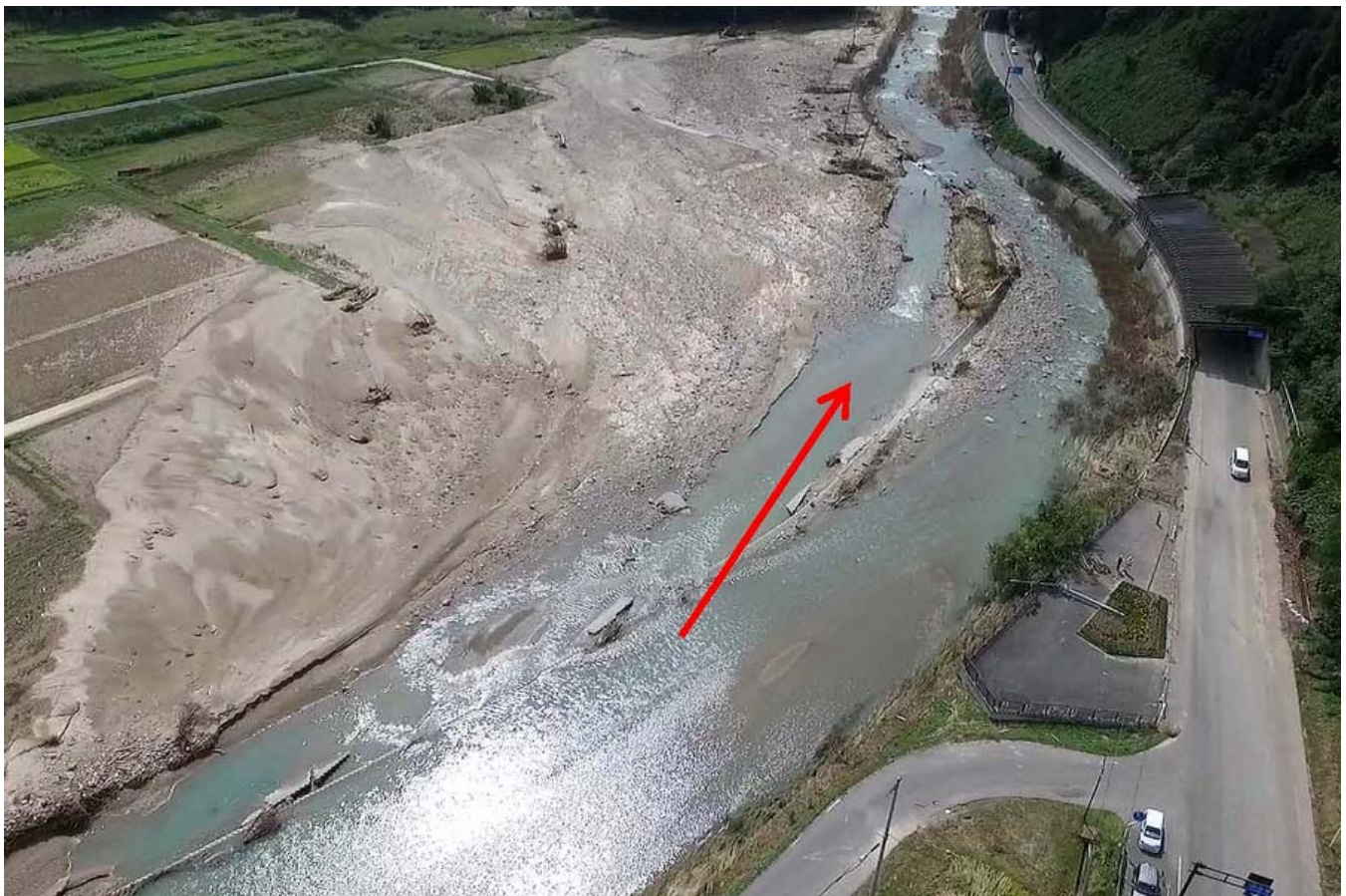
館岩川護岸崩壊（南会津町伊与戸地内）
