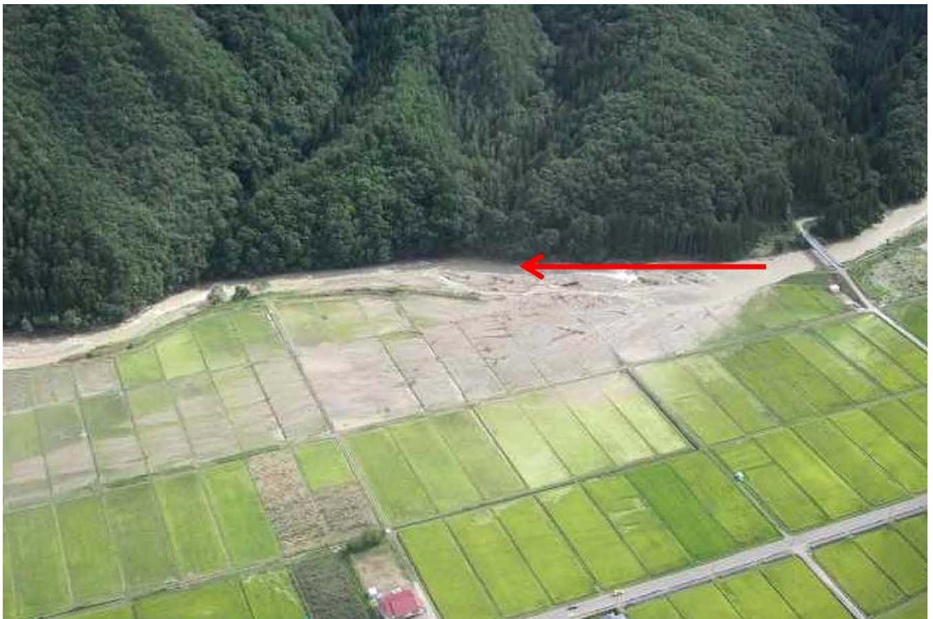
桧沢川破堤（南会津町金井沢地内）
