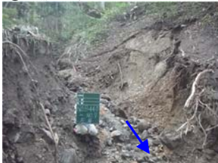
①山腹崩壊状況
