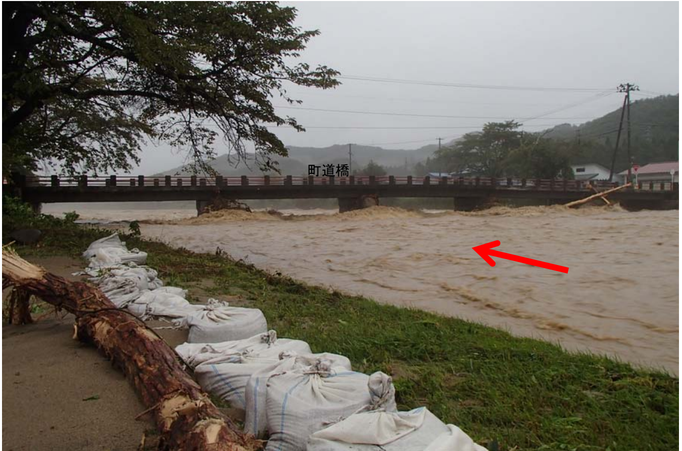
阿賀川（南会津町古内平地内）
