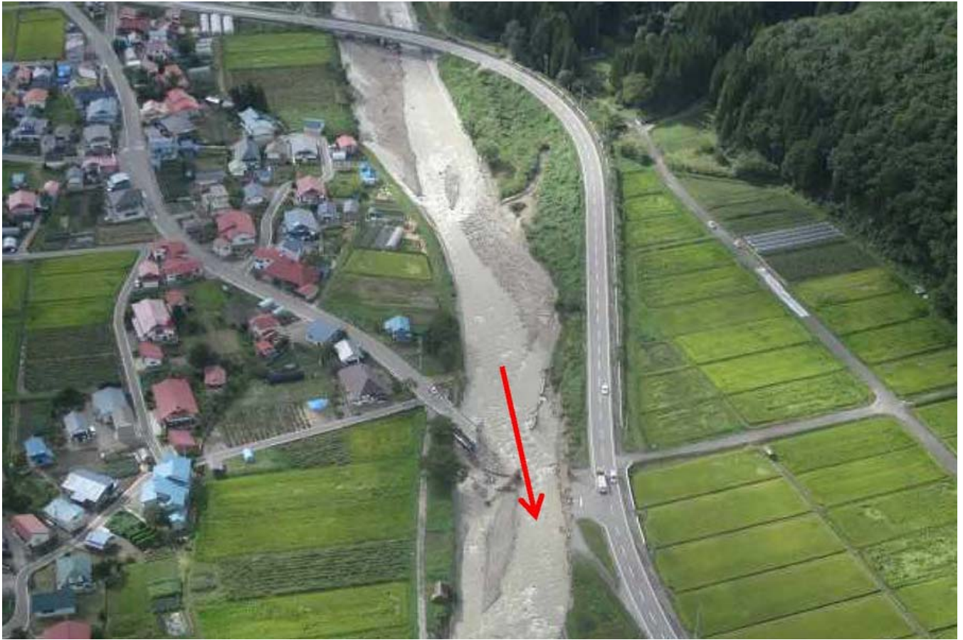
桧沢川護岸崩壊（南会津町静川地内）
