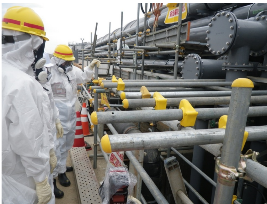
K 排水路出口の状況を確認している様子
