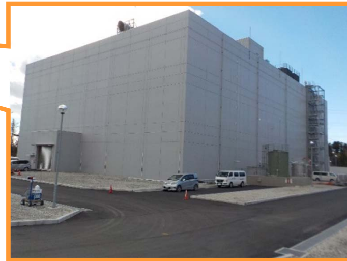
<焼却炉建屋外観> (建屋寸法：約69.0m×約45.0m×約26.5m)
