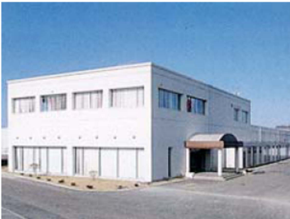
遮へい機能を有する建物内に保管
