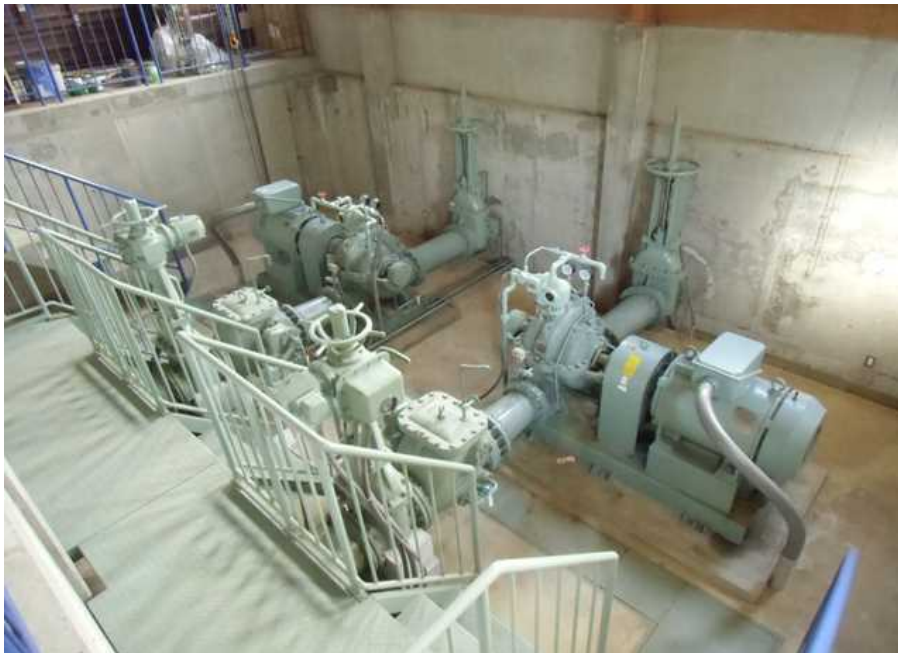
水利施設整備事業 三春南部地区(三春町)【揚水機場更新】
