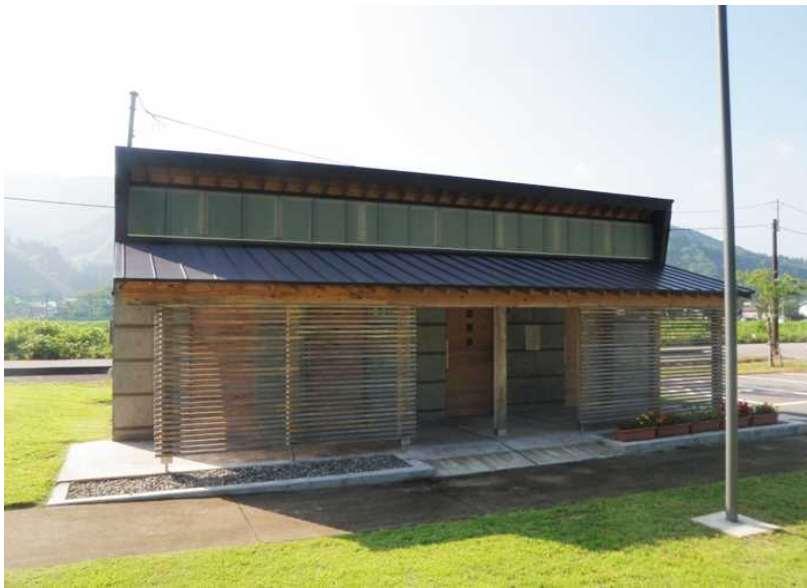
中山間地域総合整備事業 ただみ西地区(只見町)【交流基盤整備】
