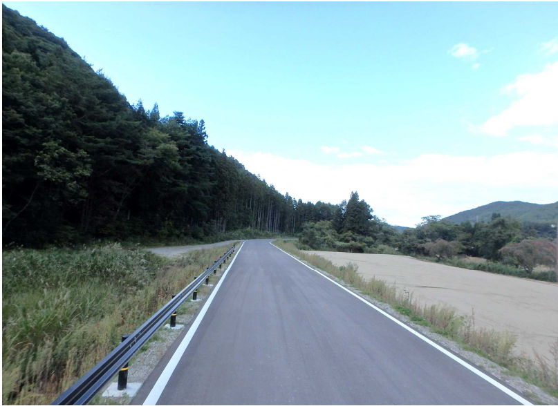
農地整備事業(通作条件整備) 糸沢3期地区(南会津町)【農道】
