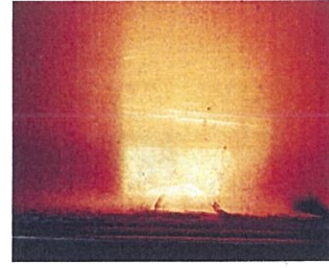
焼却炉内部 (A系) ホット試験 廃棄物燃焼状況
