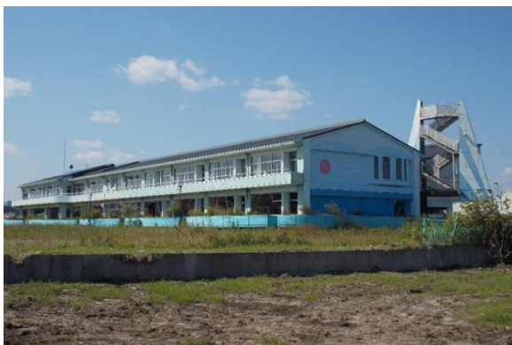
請戸小学校 (平成 27 年 9 月 22 日撮影)
