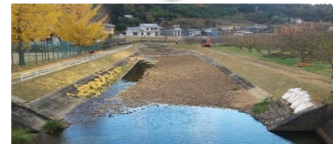
河川敷の表土剥ぎを行う実証実験
