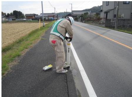
応急補修作業
