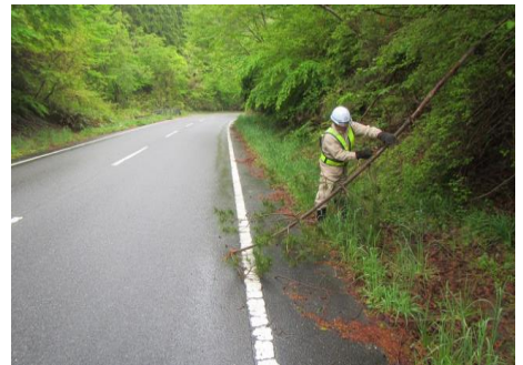
支障木撤去作業
