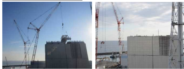
屋根パネルの取り外し
