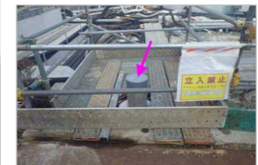
新設サブドレンピット
