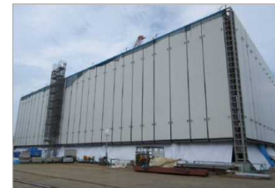
増設多核種除去設備の建屋外観
