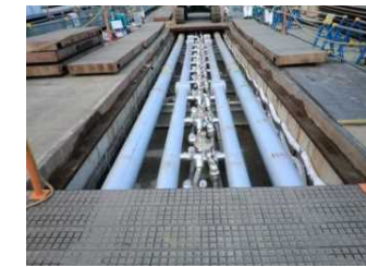
工事が完了した海側の状況
