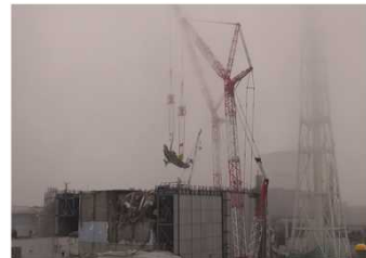
3号機使用済燃料プールからの燃料交換機撤去
