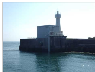
港湾口海水放射線モニタ (外観)
