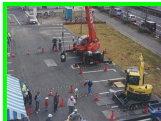
《建築重機オペ体験》
