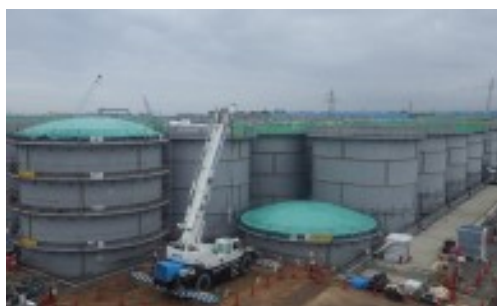
写真4：フランジタンク解体工事
