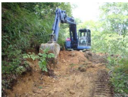
作業道の作設状況（柳津町）
