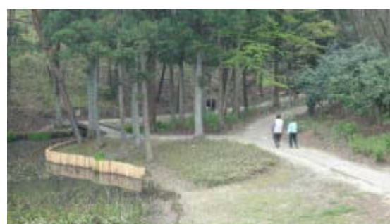
総合緑化センター植物園護岸補修 (郡山市)
