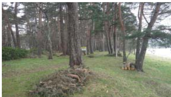
青松ヶ浜県有林危険木伐倒処理 (郡山市)
