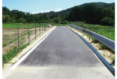
① 平成24年3月 復旧工事完了
