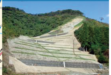
③ 平成25年12月 完成
