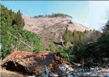
③ 地震による山腹崩壊被害 (田人町 綱木地区)
