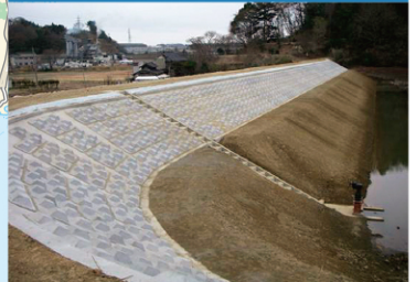
④ 平成25年3月 完成
