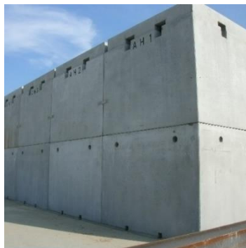
セシウム吸着装置 (KURION) 吸着塔
