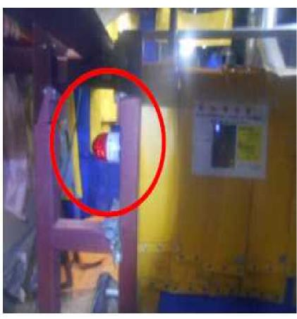
低線量及び高線量のエリア入り口に,回転灯を設置し注意喚起 (低線量は緑。高線量は赤)
