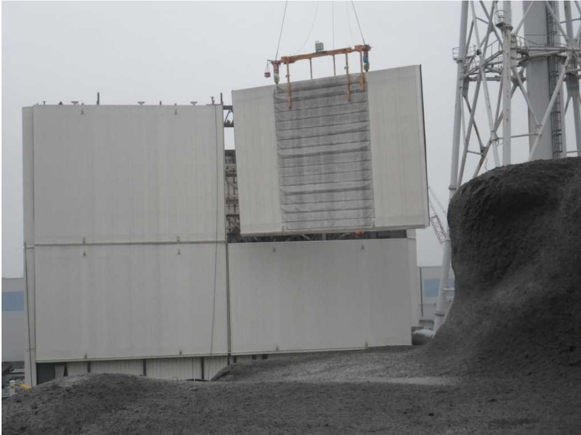
② クレーンで吊った壁パネルの状況。(午前6時22分)
