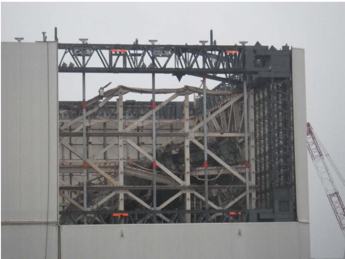
③ 壁パネルが取り外された状態の建屋カバー。(午前6時23分)
