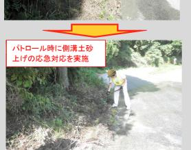
8月は3週連続で台風が接近したため、沢から流出した土砂や枯れ葉などにより側溝が詰まり、道路にあふれてしまった箇所があり、パトロールでの応急対応や機械を入れての解消作業を行いました。
