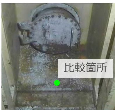
床表面線量比較箇所
