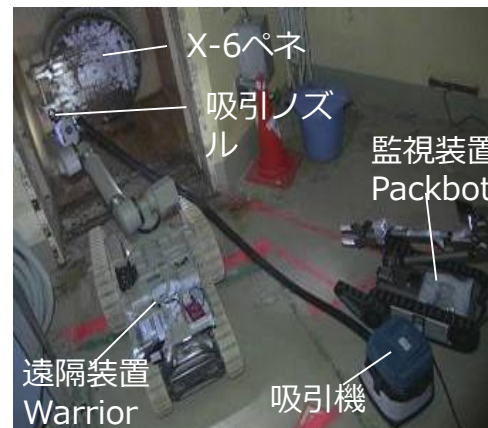
吸引除染作業状況
