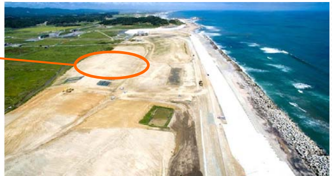
整備中の らち 浜地区防災緑地(写真は植樹前)
