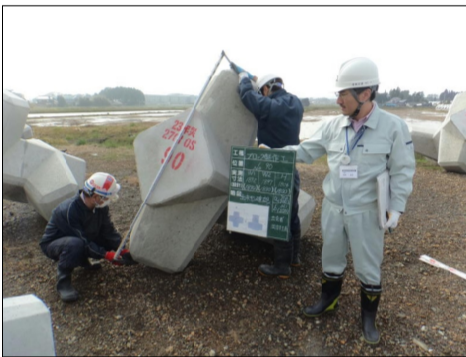
消波ブロック出来型確認中の岡部主査(右)
