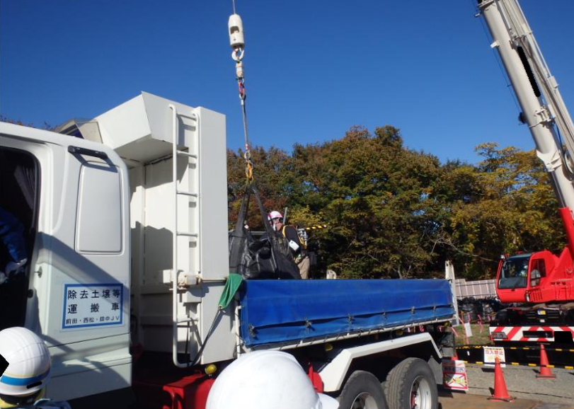
除去土壌等の車両積込状況確認
