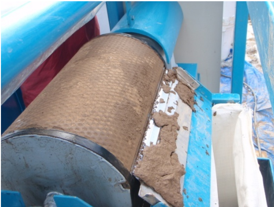
写真2 汚泥処理用真空脱水機
