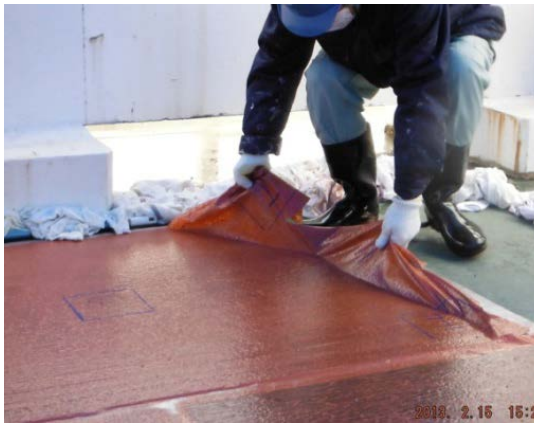
写真3 乾燥後の塗膜の剥離作業
