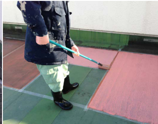
写真2 塗料の塗布作業
