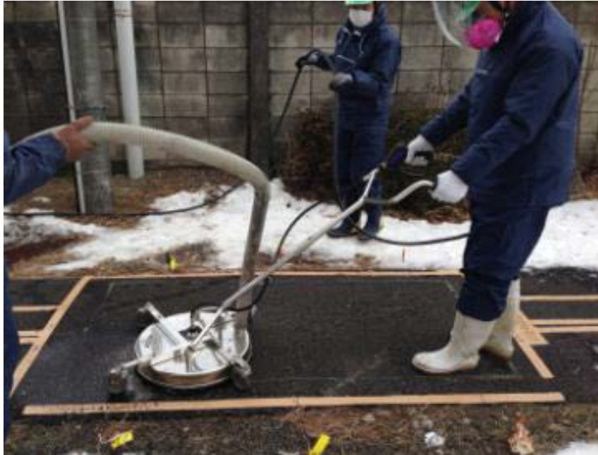
写真1 アスファルト舗装面の洗浄
