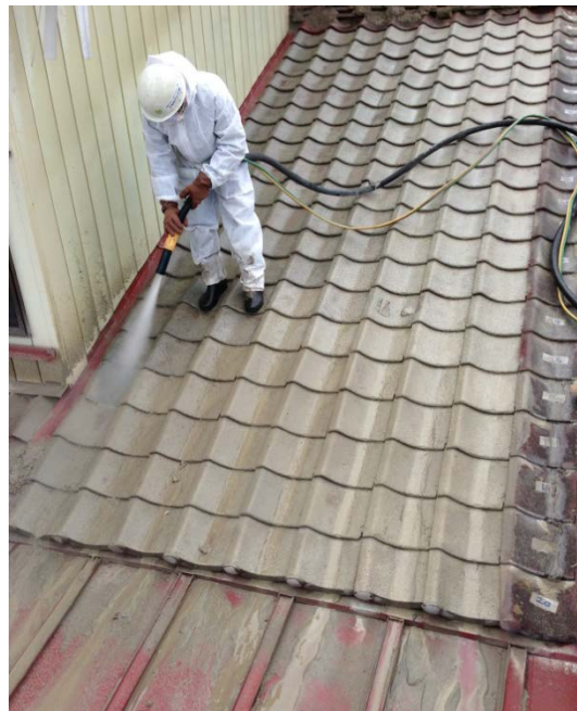
写真2 湿式ブラスト洗浄後の 高圧水洗浄
