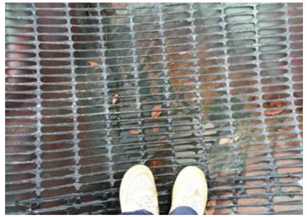
写真2 ジオグリッド敷設後の様子
