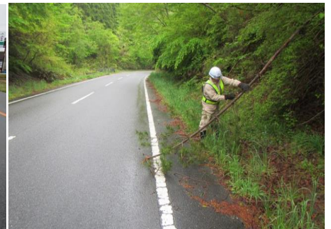
支障木撤去作業
