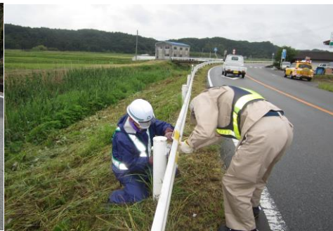
応急補修作業
