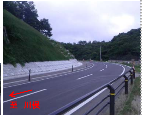
急カーブ箇所を改良(7月25日撮影)
