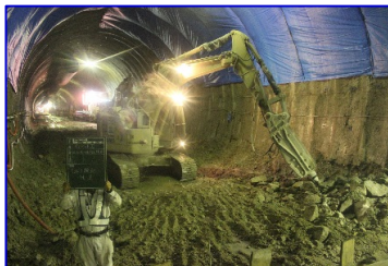
掘削した岩の 小割作業
