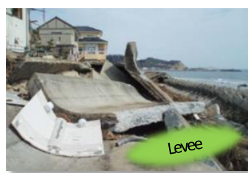
Iwaki City Levee
