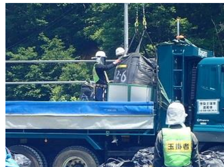
除去土壌等の車両積込状況確認
