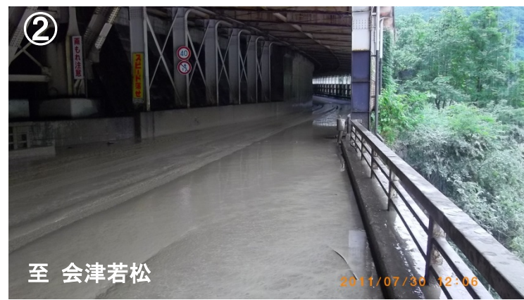
平成23年7月新潟・福島豪雨災害での国道252号の冠水
