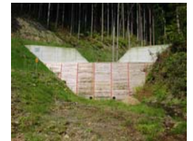
治山ダム (矢祭町 入山地区)
