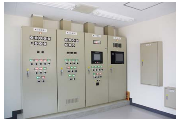
農業集落排水統合補助事業（白河市「五箇中央地区」）
