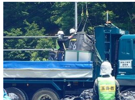
除去土壌等の車両積込状況確認
