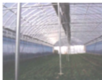
中柱（仮支柱）設置の写真
