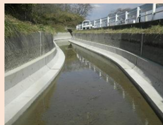
用水路補修工事
