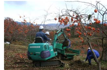
剥土を保管場所へ移動
