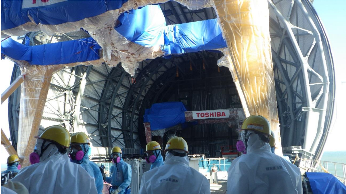
② 3号機原子炉建屋燃料取り出し用カバー内の確認状況。燃料取扱機（奥側）・クレーン（手前側）の設置状況の確認並びに使用済燃料の取り出し方法等を確認した。
