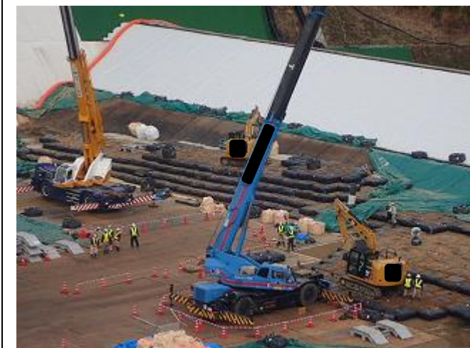
下流側埋立地の埋立状況の確認
