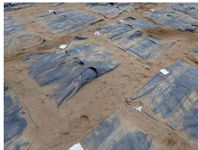
同左（土砂による空隙充填）
