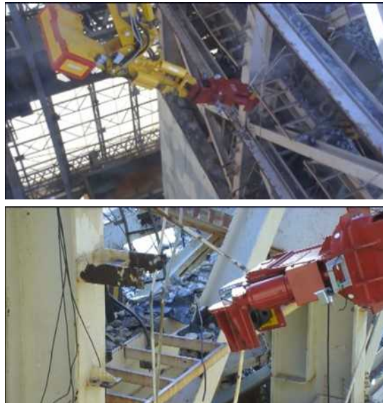
散水設備設置のための支障鉄骨等撤去作業における、カッターによる切断の状況
