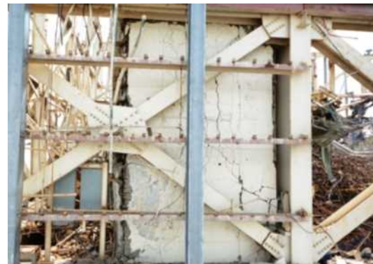
西面の壁状況
