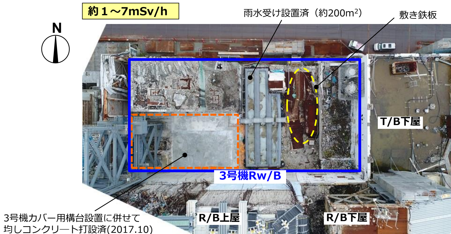
3号機Rw/B屋根の状況
