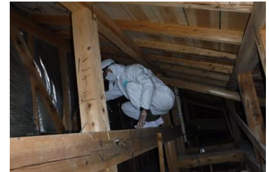
天井裏の様子
