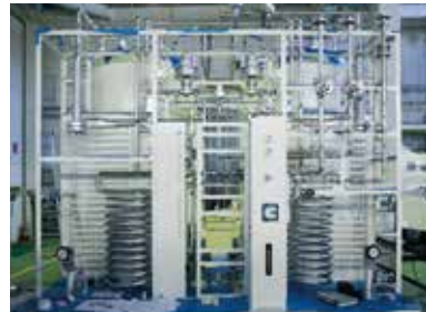
製作した配管やバルブ
