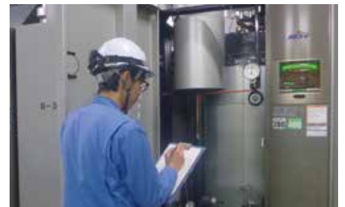
施設の点検風景。
