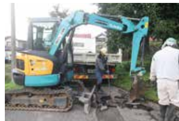
水道管の取替工事
