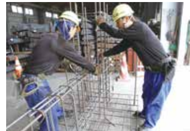
鉄筋を組み上げる作業
