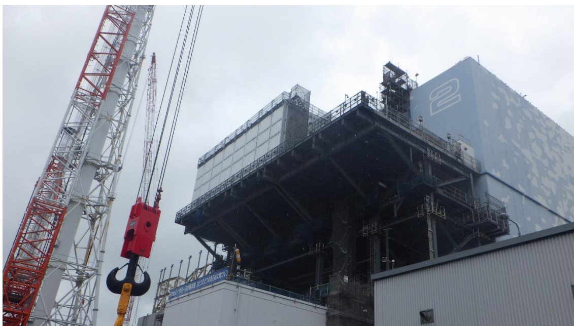
① 2号機原子炉建屋西側前室の外観
