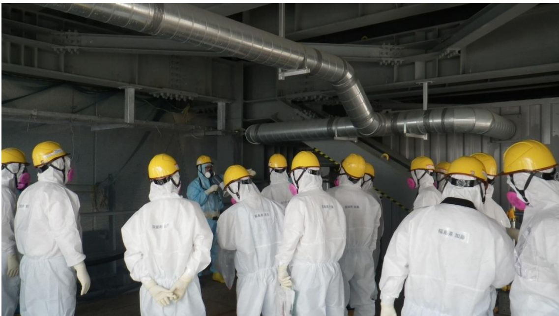
③ 2号機原子炉建屋西側前室の下のフロアに設置された前室内の循環換気設備配管等を確認している様子
