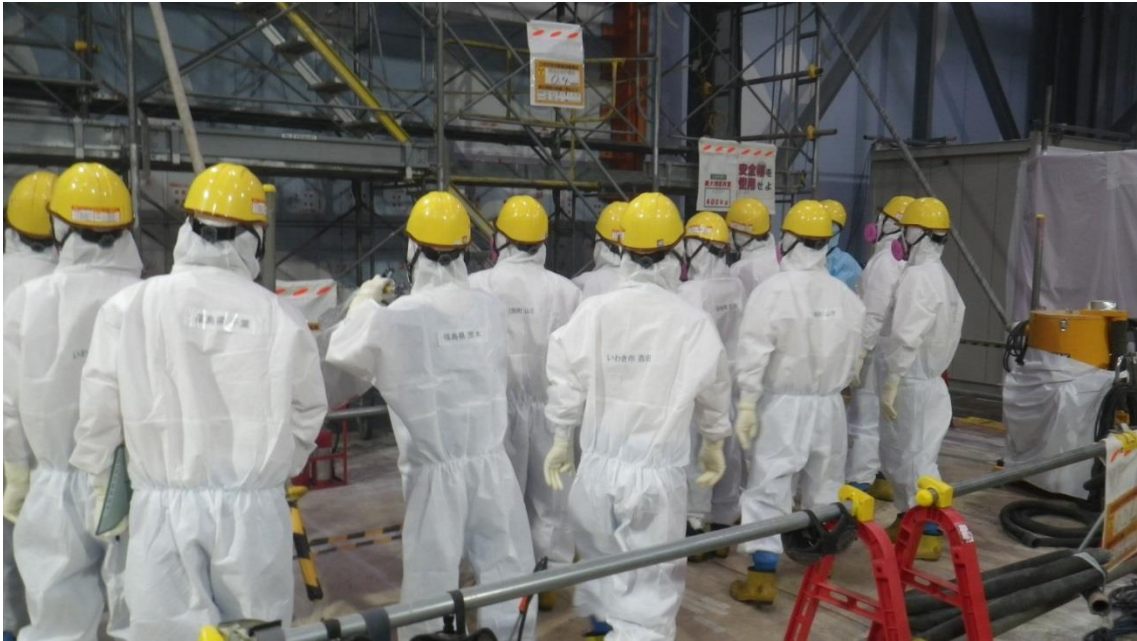
② 2号機原子炉建屋西側前室内で開口設置部を確認している状況。開口設置工事の進捗状況や前室の構造を確認した。
