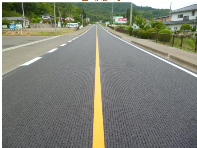
至 福島市街地 (舗装打設完了後の現場状況)
