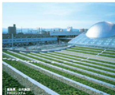
図 2-1-17 屋上緑化の事例
