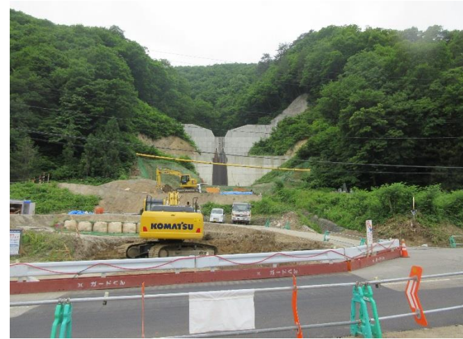
南会津町内川地内
